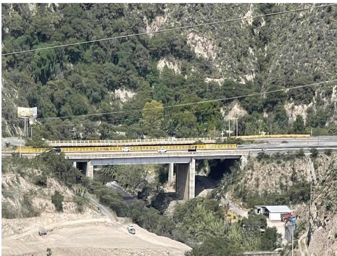
Figura 1. Vista general del Puente de Guayllabamba y su integración en el entorno geomorfológico del valle, mostrando la disposición de los vanos, las pilas de hormigón armado y el tablero mixto sobre el cauce del río Guayllabamba (fotografía de los autores capturada con el dron).
