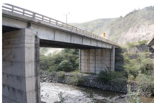
Figura 4. Vista general del Puente de Guayllabamba en sentido longitudinal, mostrando la disposición de los vanos, las pilas de hormigón armado y su relación con el cauce del río (imagen obtenida mediante RPAS).
