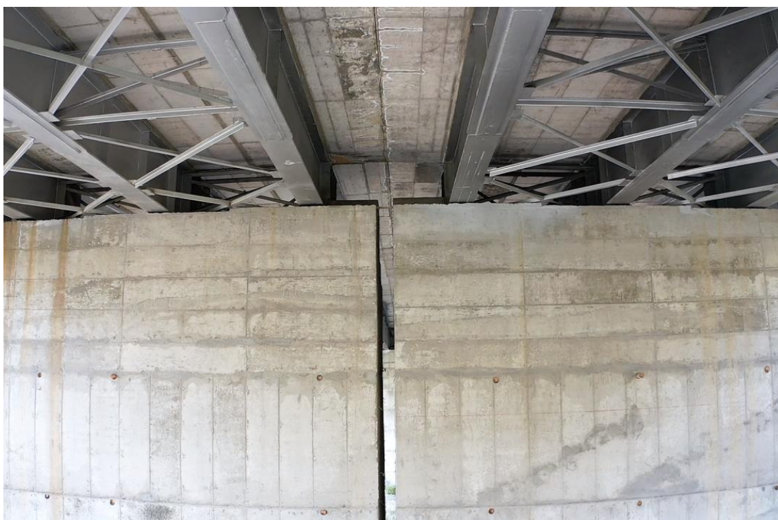
Figura 5. Detalle de la junta vertical entre cuerpos de hormigón en la zona de apoyo del tablero del Puente de Guayllabamba, correspondiente a una discontinuidad constructiva prevista en el diseño, donde se aprecian huellas de filtración superficial asociadas al envejecimiento del sellado (imagen capturada mediante RPAS).
