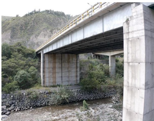
Figura 2. Vista del alzado oeste del Puente de Guayllabamba, obtenida mediante RPAS (drone), donde se aprecian el tablero metálico, las pilas de hormigón armado y su relación con el cauce del río y el entorno topográfico inmediato (fotografía de los autores).
