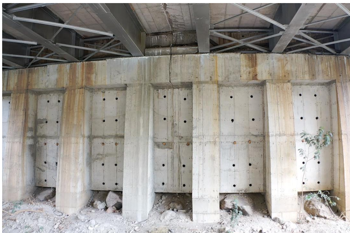
Figura 6. Vista del intradós del tablero y de la zona superior de una pila del Puente de Guayllabamba, donde se observan chorreos de lixiviación, fisuración vertical y alteraciones cromáticas del hormigón asociadas a la presencia recurrente de humedad (imagen capturada mediante RPAS).
