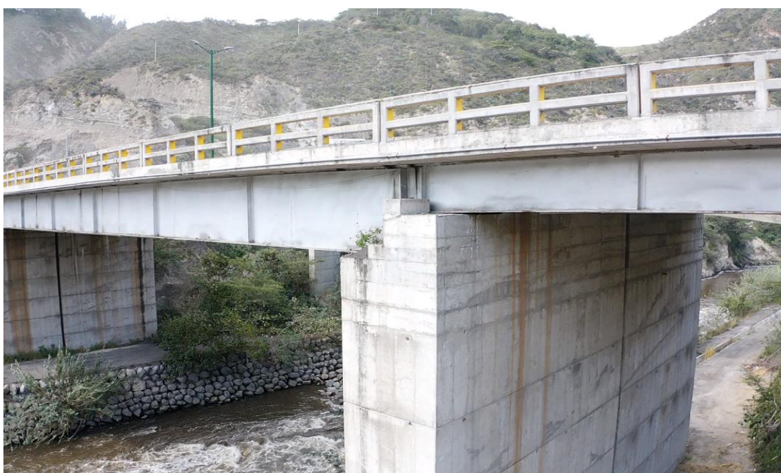
Figura 7. Detalle del encuentro entre el tablero metálico y la pila de hormigón armado del Puente de Guayllabamba, donde se aprecian huellas de escorrentía y lixiviación vertical asociadas a procesos de humedad superficial y envejecimiento del material (imagen capturada mediante RPAS).
